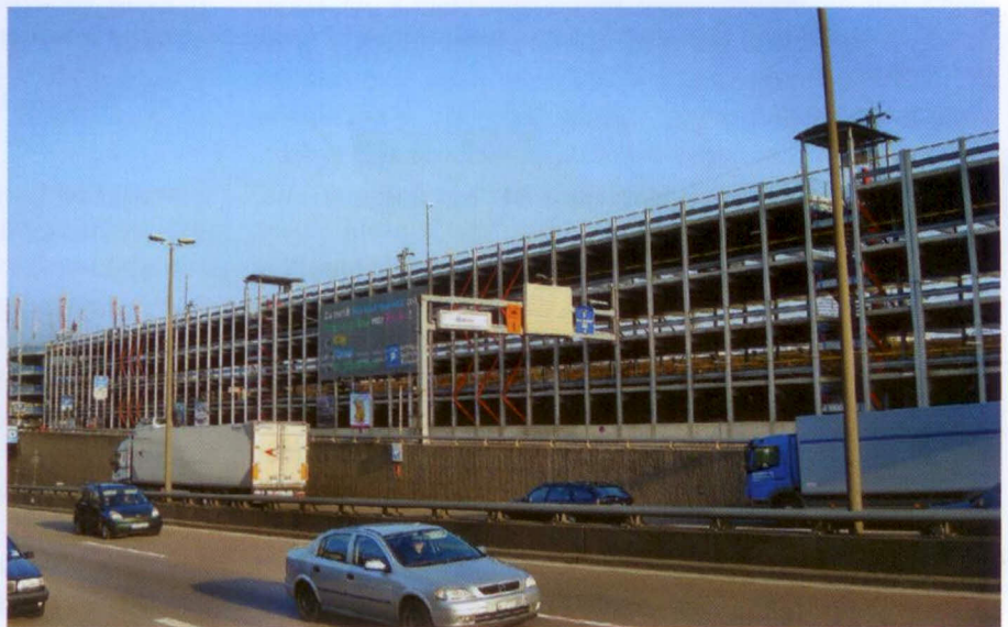
Rys. 6. Widok ogólny parkingu wielopiętrowego w Bazylei
