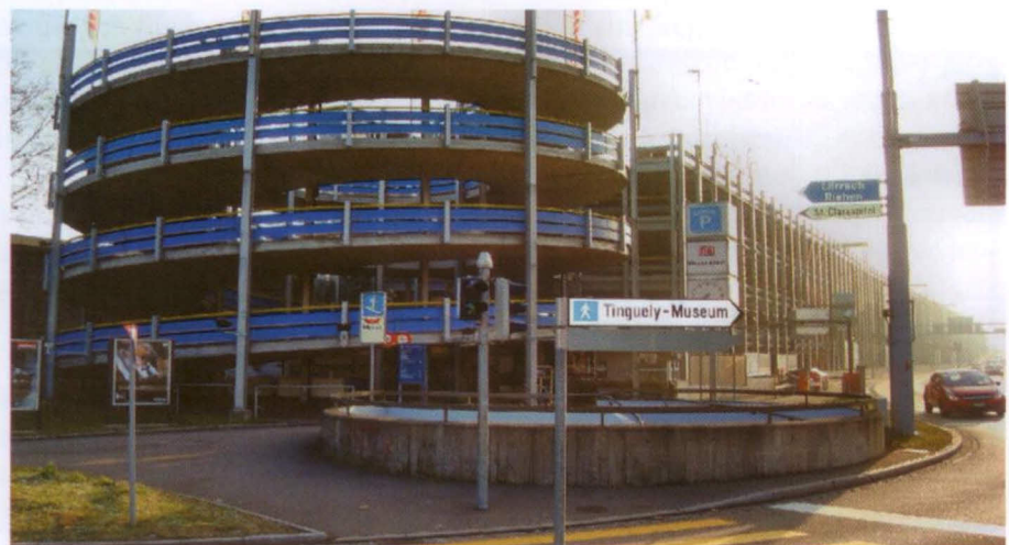
Rys. 7. Rampa wjazdowo-wyjazdowa parkingu wielopiętrowego w Bazylei
